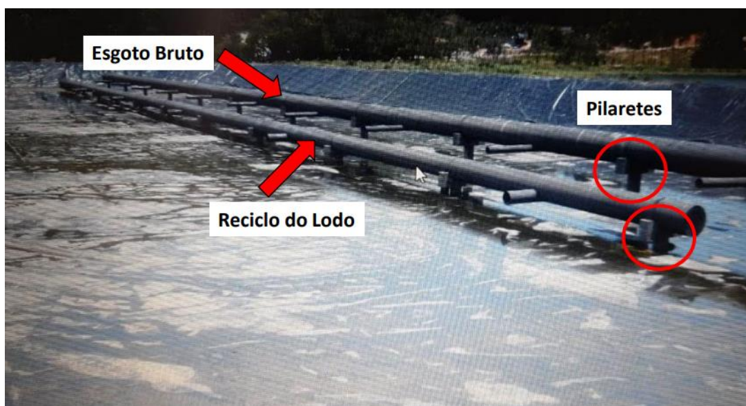
Figura 7 - Vista parcial das tubulações inseridas dentro do tanque de aeração
