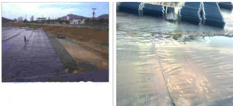
Figura 2 - Aplicação da geomembrana no tanque de aeração (lagoa)
