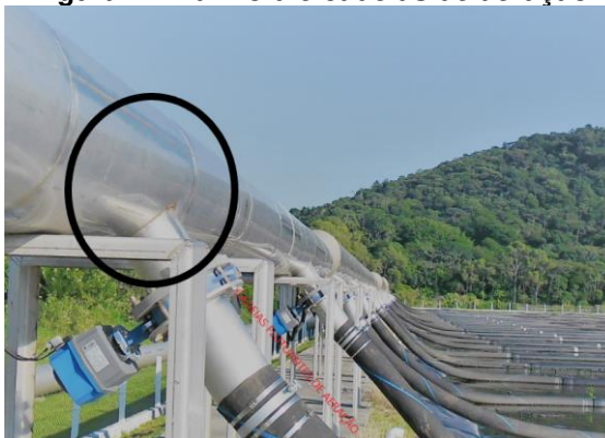
Figura 1 - Manifold e cadeias de aeração
