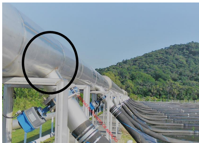
Figura 12 - Manifold e cadeias de aeração
