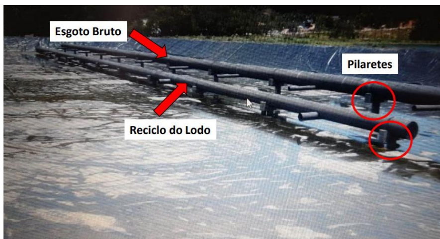
Figura 2 - Vista parcial das tubulações inseridas dentro do tanque de aeração
