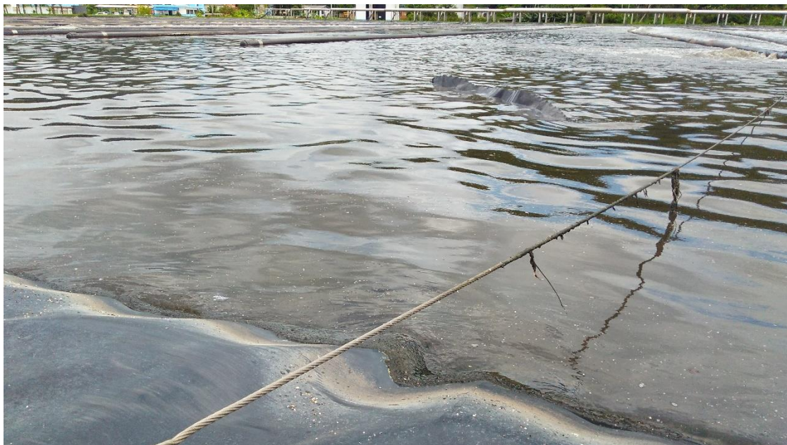
Figura 3 - Flutuação na geomembrana do tanque de aeração
