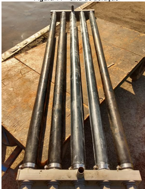
“Figura 11 - Grid de aerção
