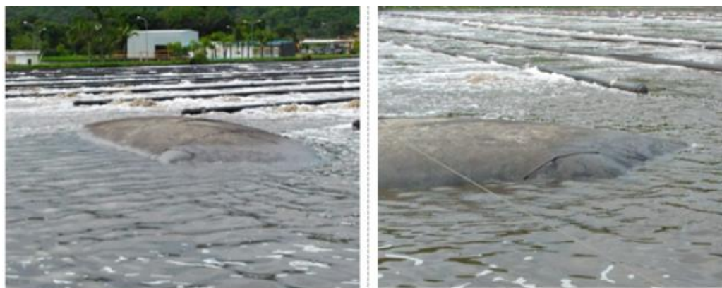
Figura 4 - Formação de bolhas no interior do tanque de aeração
