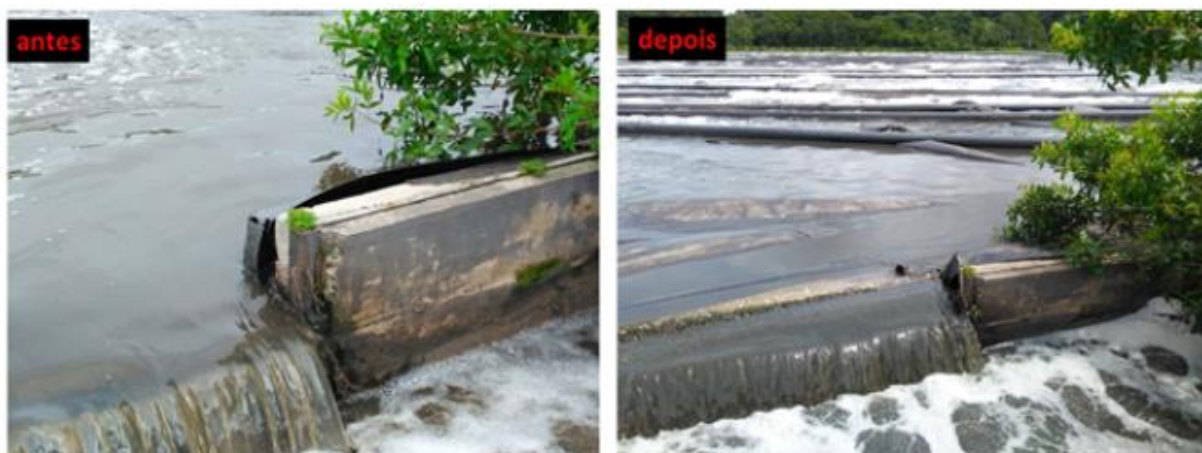
Figura 5 - Visão parcial do vertedouro de saída e descolamento da manta
